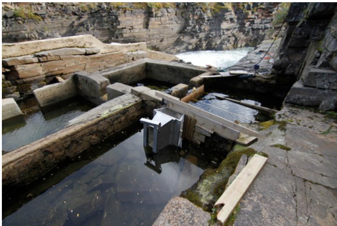
Figur 16. Montering av fisketeller i laksetrappa i Vestre Jakobselv.
